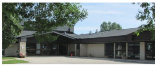
En janvier 2019, on a remplacé la porte de la salle de radiologie au Arborg and District Health Centre.
